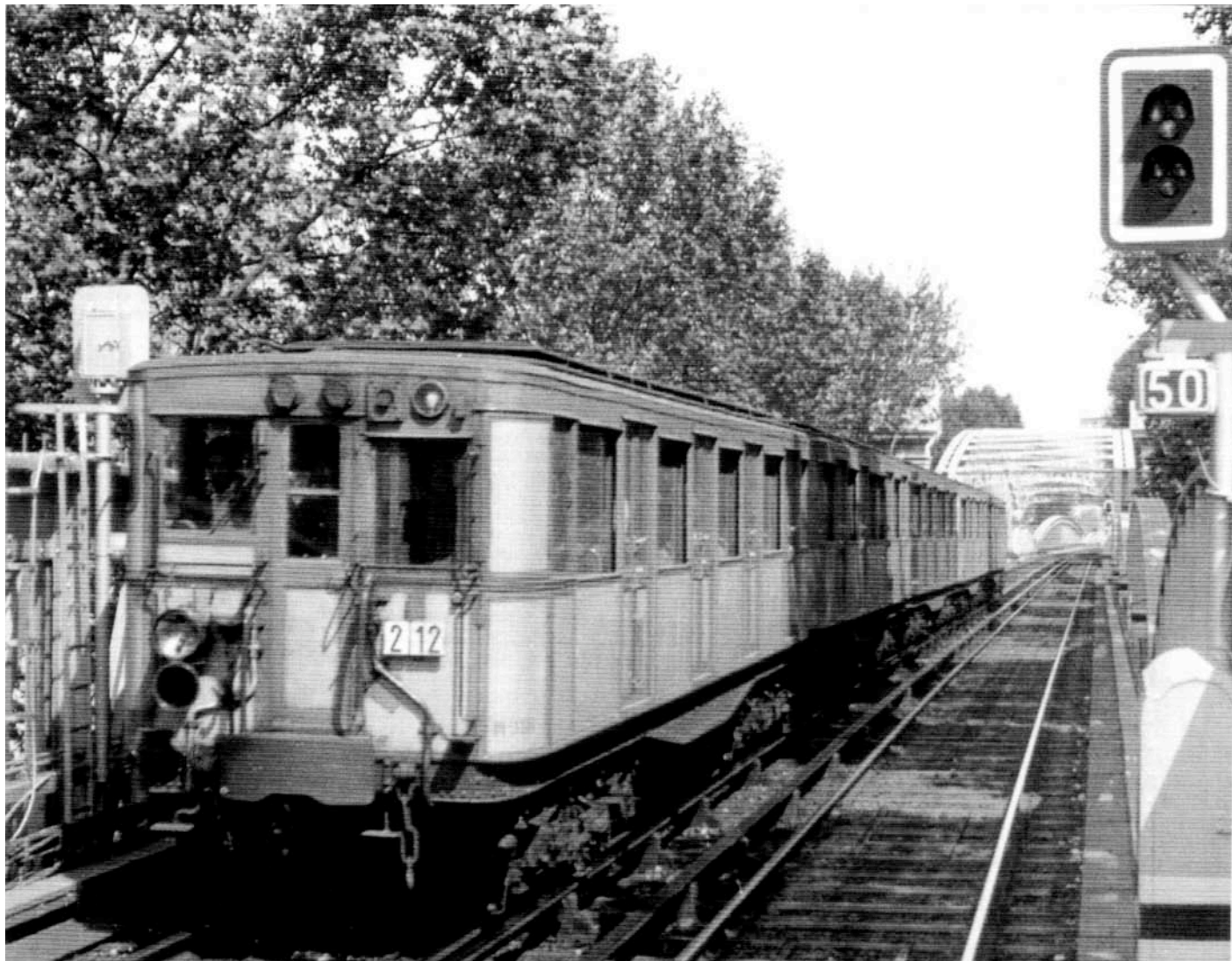
Rame "Sprague" grise sur la ligne n°2. Photo Yves DUPORT.
