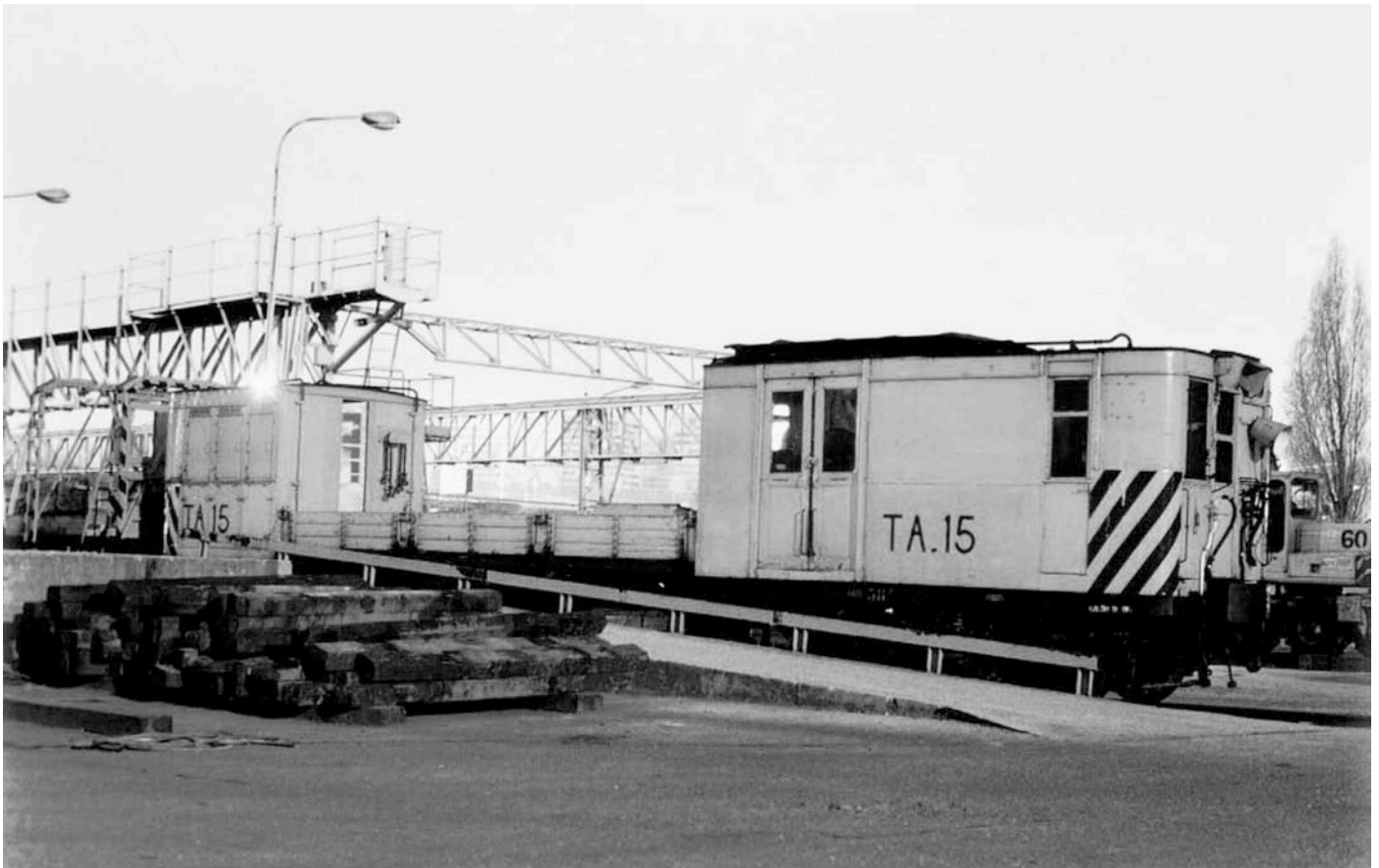
Ci dessus : vue d'un tracteur Sprague-Thomson identique au T 94, aux Ateliers de la Villette.
