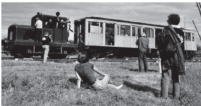
Circulation de la M. 268 pour le centenaire du métro ! (Photo Julian Pepinster)
