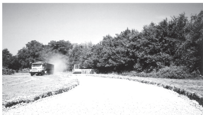
Construction d'une route ? Et non ... c'est bien de l'assiette de la future voie qu'il s'agit !
