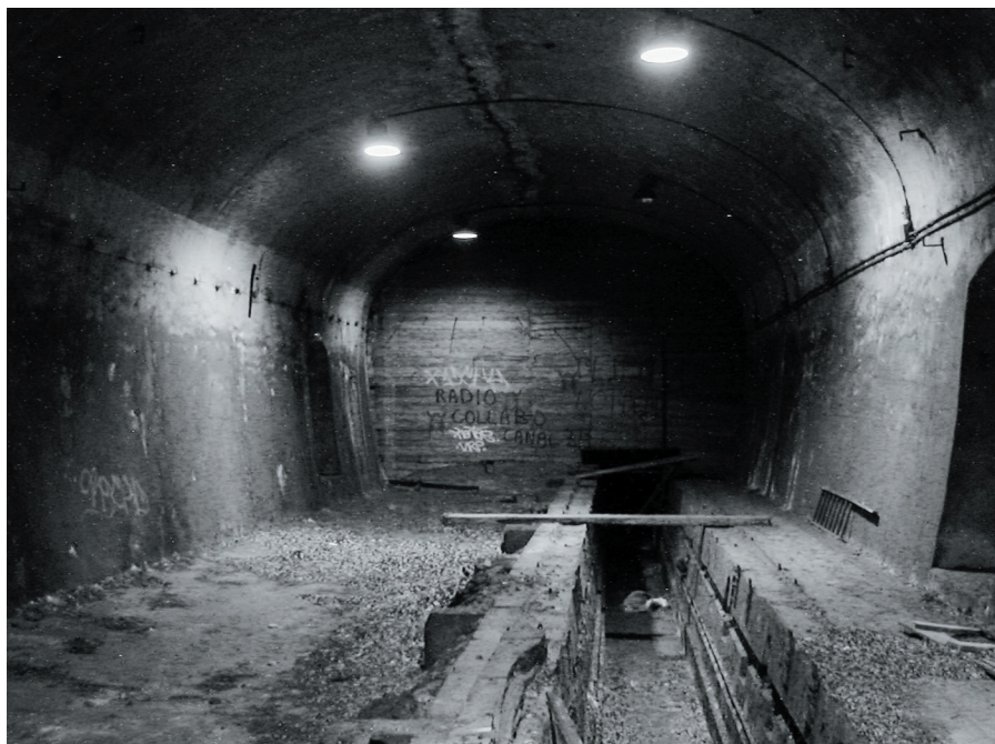
Vue de l'ouvrage prise en 2004. Il ne subsiste qu'une vingtaine de mètres de tunnel, avec fosse de visite, sans voie, au milieu de nulle part ! (photo Julian Pepinster)
