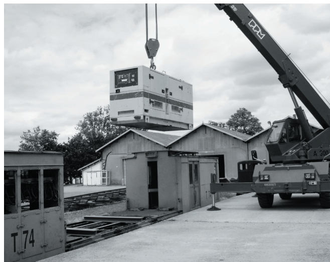
Positionnement du groupe de 180 KVA sur le T. 74. (photo Dominique Craquelin)
