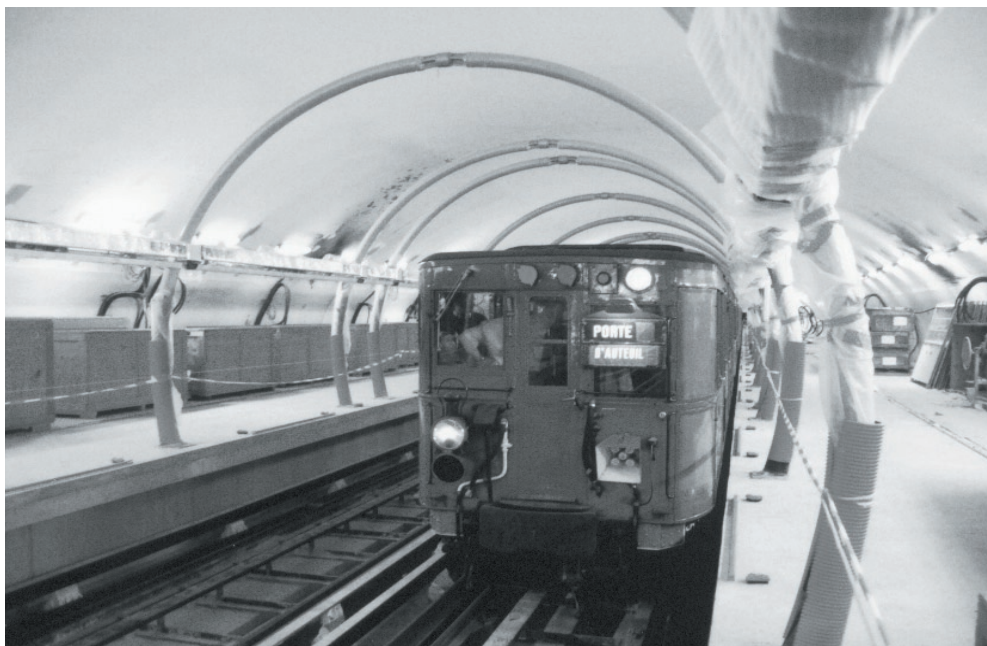
C'est dans une station en cours d'achèvement que le tout premier train de voyageurs est entré à Olympiades dans la nuit du 29 au 30 octobre 2006. La situation en travaux ne permettait pas que les visiteurs y descendent en nombre ; toutefois quelques privilégiés ont pu prendre des photos uniques ... (photo Erwann Jouan)
