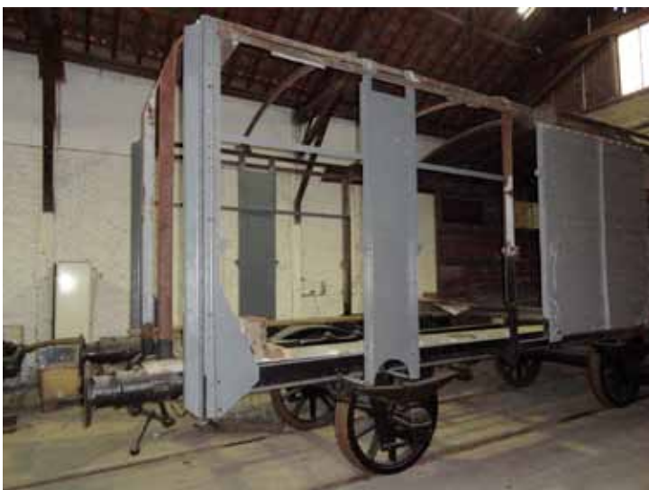
Fin des travaux de tôlerie de la première moitié du wagon Chemilly. (D. Craquelin).
