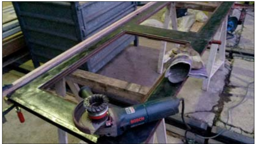
Le brossage d'une face de porte occupe une demi-journée. La durée du travail a été raccourcie en faisant une première « passe » au dérouilleur pneumatique afin de faire « sauter » la peinture, poursuivie par une finition à la brosse électrique (A. Marcinkiewicz)
