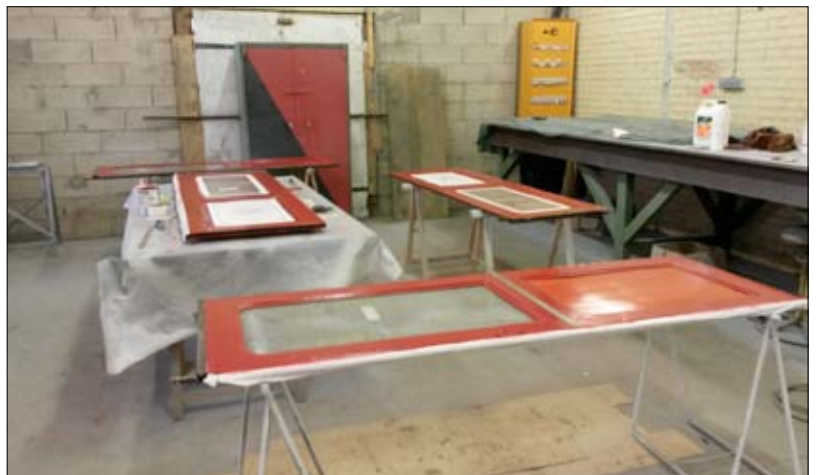
Le bon côté des choses, c'est que les 128 couches de peinture peuvent être menées par groupe de quatre ou cinq opérations simultanées ! (A. Marcinkiewicz)
