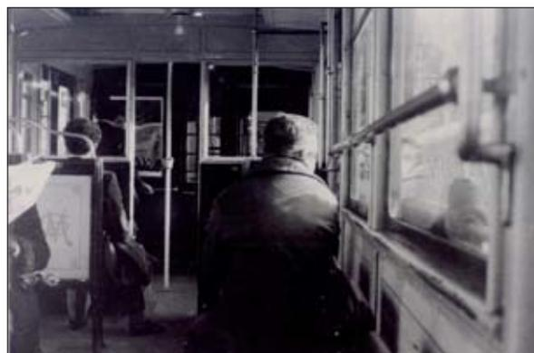
Les banquettes remplacées par des strapontins (ici dans une motrice 500 vue en 1972 sur la ligne 2) - ou par des « places debout » - ne furent jamais réinstallées. (coll. A. Wright).
