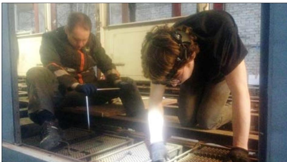
*Opération en même temps lourde et délicate, car les composants en fonte se brisent facilement : la dépose des bancs de résistances commencée le 12 mai.
