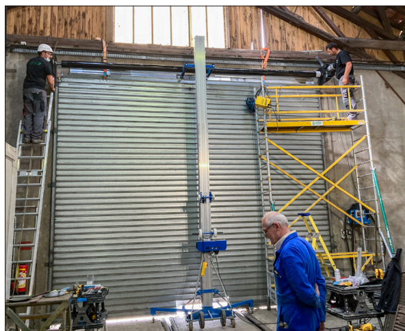
La délicate insertion du nouveau tambour d'enroulement du rideau, désormais fonctionnel (J. Pepinster).
