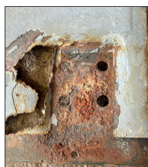
Ci-dessus, vue de la face après dépose des tôles corrodées le 3 septembre. (B. Faudeux)
