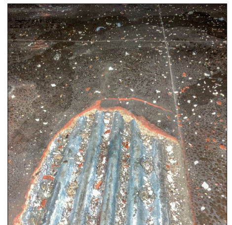
Exemple de gondolement et décollement du terrazolith. (J. Pepinster)
