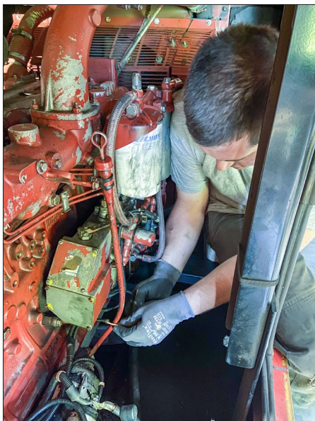
12 juillet : pose d'un démarreur de remplacement, celui-ci étant manquant. (A. Marcinkiewicz)
