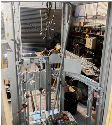
Vue du poste de conduite en peinture le 10 juillet. (J. Pepinster)
