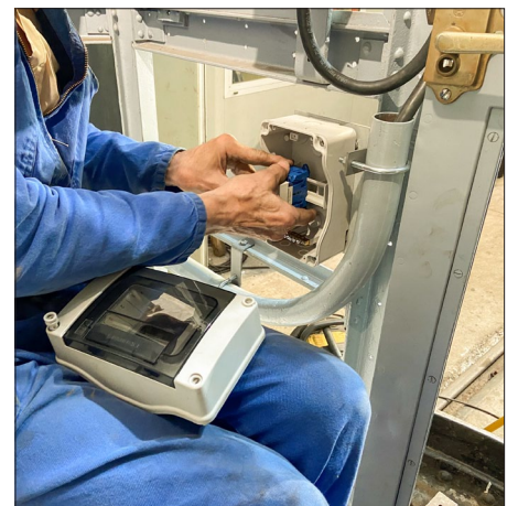
Montage de l'interrupteur des circuits basse tension. (A. Marcinkiewicz)
