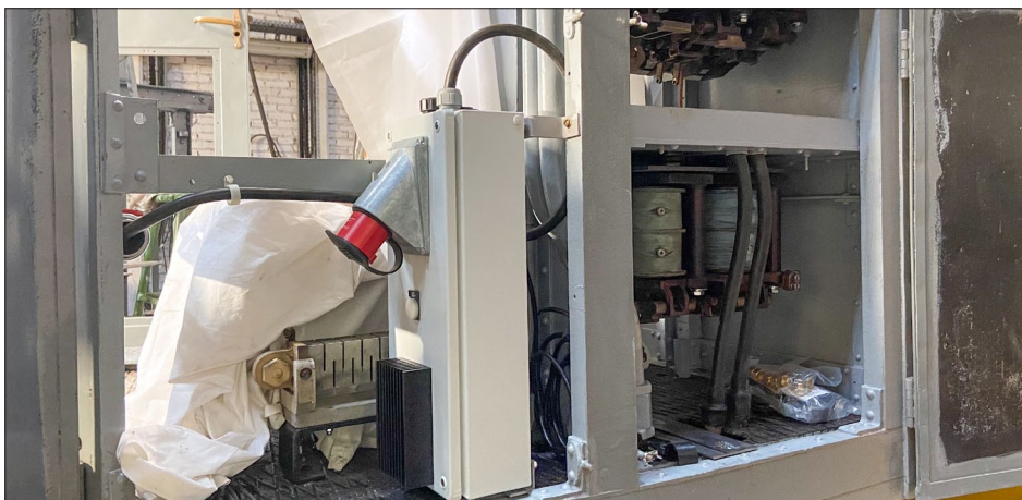
La nouvelle prise de parc, vue le 12 juillet ; à droite, les premiers câbles commande neufs reposés. (A. Marcinkiewicz)
