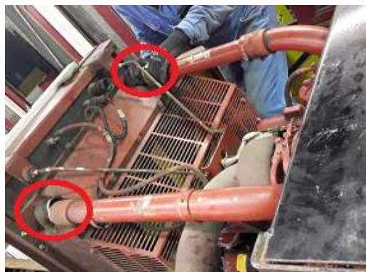
Découpe et pose de la mousse insonorisante sur le bas de cadre du groupe électrogène après les 6 couches de « beige Sprague » posées dans la semaine.
